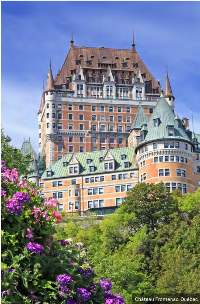
Château Frontenac, Québec
